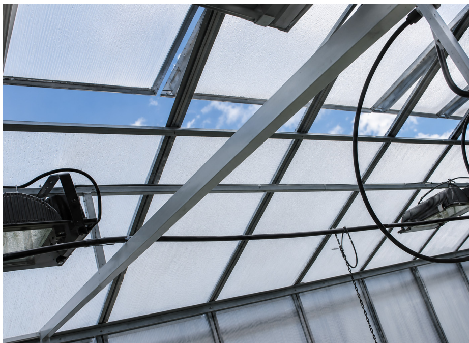
Fig. 3.6. Ventilație prin deschiderile acoperișului (Foto: Sarvaș)
