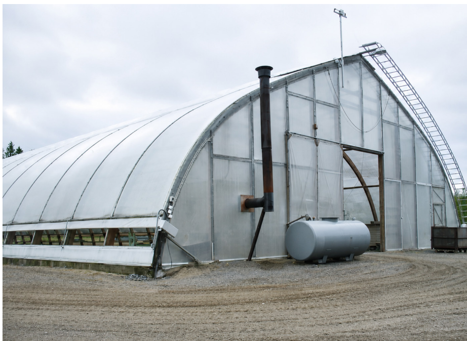
Fig. 3.3. Seră din folie de polietilenă cu ventilație laterală (Foto: Sarvaš)
